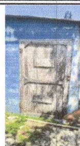
FOTO 8: Fabricación e instalación de puertas de metal en módulos
