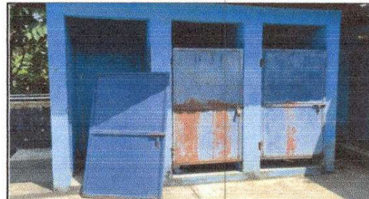
FOTO 4: Fabricación e instalación de puertas de metal en baños
