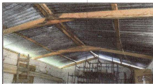
FOTO 10: Sustitución de lámina, por lámina troquelada aluzinc calibre 26 Y Sustitución de estructura de soporte de madera, por metal
