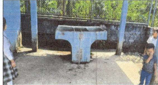
FOTO 2: Sustrucción de pila de cemento de dos lavadero
