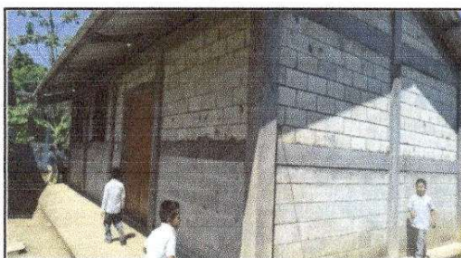
FOTO 11: Pintura en muros exteriores e interiores
