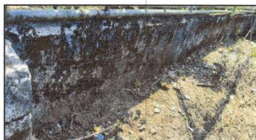
FOTO 12: Pintura en muros exteriores e interiores
