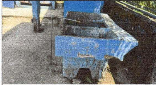
FOTO 1: Sustrucción de pila de cemento de dos lavadero
