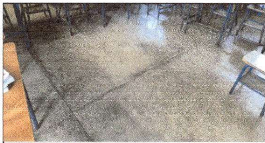
FOTO 5: Sustrucción de piso de cemento liquido por piso cerámico
